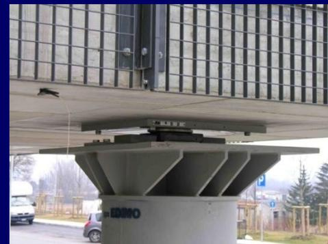
**I “FIGLI”:** *Curved Sliding Surface (CSS) italiani (materiali a scorrimento polietilenici e poliammidici). Utilizzati per la prima volta in Italia nel Progetto C.A.S.E. a L’Aquila*
