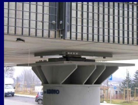
**I “FIGLI”:** *Curved Sliding Surface (CSS) italiani (materiali a scorrimento polietilenici e poliammidici). Utilizzati per la prima volta in Italia nel Progetto C.A.S.E. a L’Aquila*
